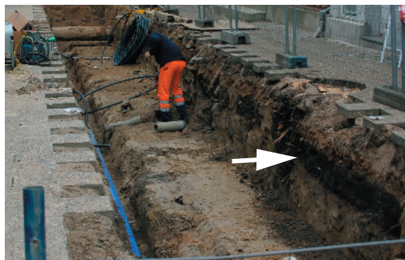
Arbejdsbillede fra Østergade. Her ses de middelalderlige kulturlag tydeligt i profilen.
